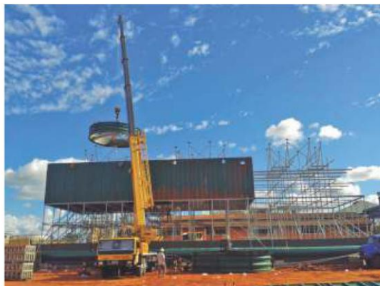
Montagem realizada pela nossa equipe no Grupo Tereos – Unidade Tanabi
